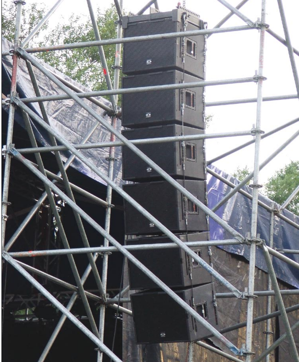
Główny system składał się z sześciu (1,5 systemu) podwieszonych zestawów Cobra 4.
