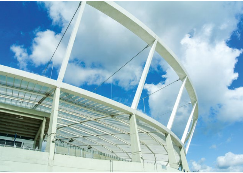
Oprócz nagłośnienia trybun i boiska dodatkowe 80 zestawów głośnikowych zainstalowano na 30 słupach, które otaczają stadion.
