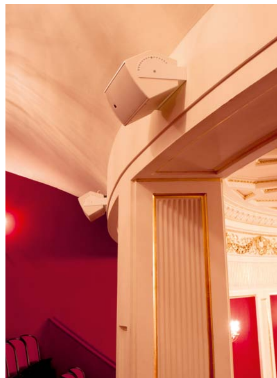
Dogłośnienie trzeciego balkonu stanowi linia opóźniająca złożona z czterech zestawów L'Acoustics SXT.
