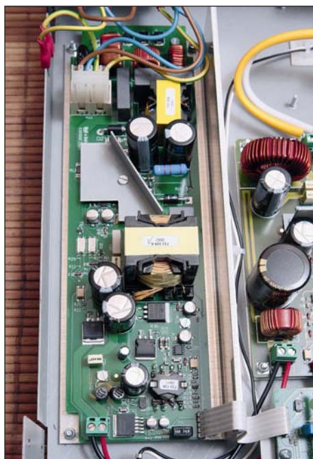
Sygnaly przepływają pomiędzy płytkami za pośrednictwem taśm, a jedynie tam, gdzie prąd osiąga wyższe wartości zastosowano grube przewody jednożyłowe.
