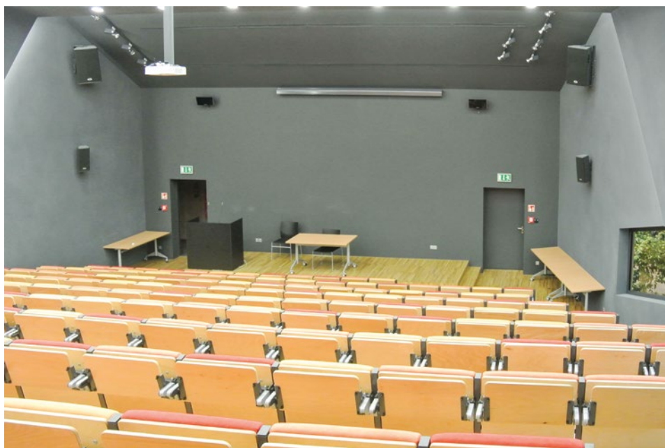
Nagłośnienie głównej sali konferencyjnej zaprojektowano w oparciu o urządzenia Dynacord – dwa zestawy głośnikowe VL 152 oraz dwa dogłaśniające VL 262.
