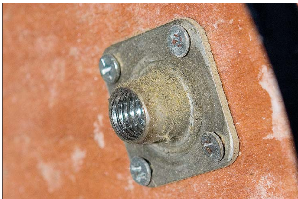
Dopiero zaglądając do wnętrza obudowy widzimy, że jednak zestaw montuje się do stelaża za pomocą śrub, a nie po prostu „na wtyk”.
