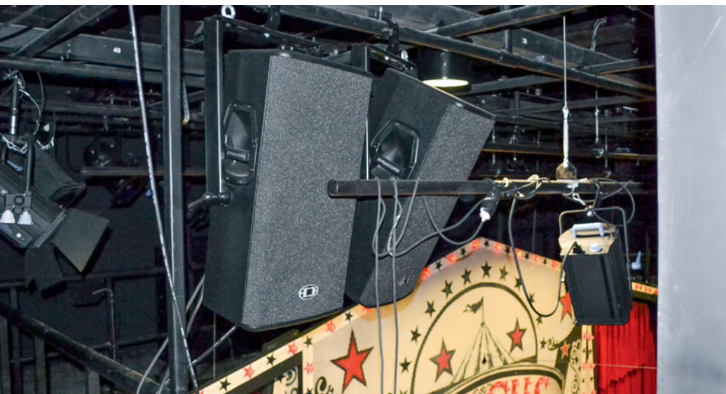
Zestawy VL 122 można zainstalować do kratownicy nad widownią Sceny Margines, z przodu i/lub z tyłu...
