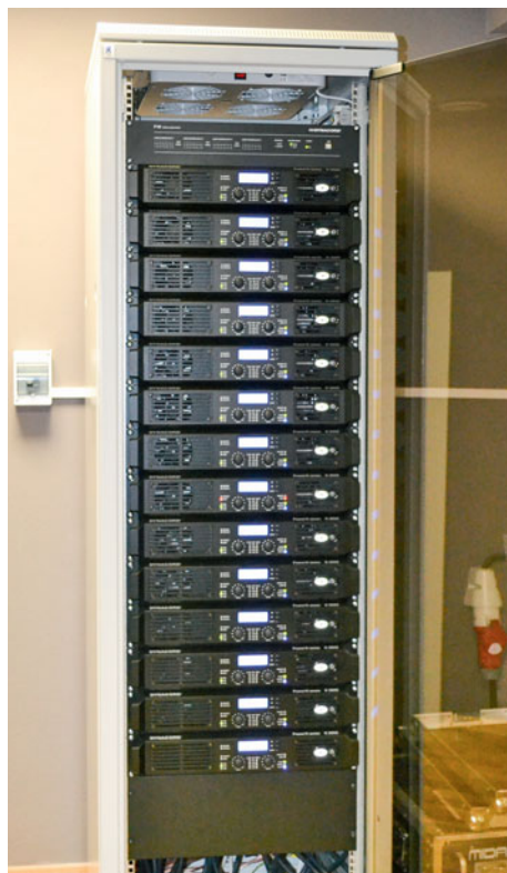
Za sterowanie i odpowiedni routing sygnału w systemie nagłośnieniowym Dużej Sceny odpowiada matryca Dynacord P64-1500, zaś napęd stanowi 14 wzmacniaczy Dynacord H2500.
