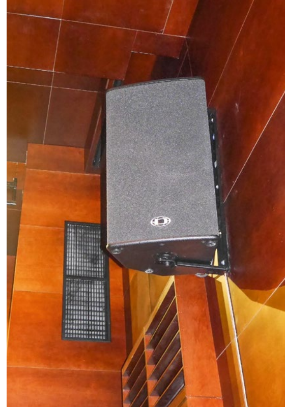
Nagłośnienie frontowe składa się z dwóch zestawów VL152 oraz dwóch zestawów subniskotonowych SUB18 Dynacorda.
