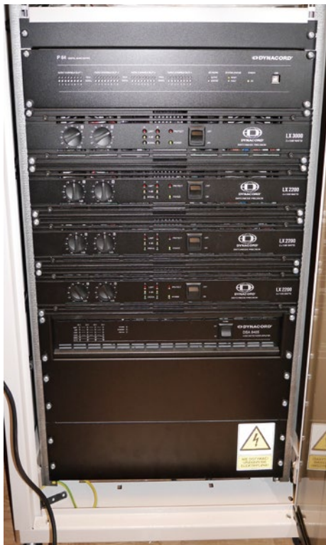
Punktem centralnym systemu jest matryca Dynacord P64. Pod nią zestaw końcówek mocy napędzających zestawy głośnikowe systemu.
