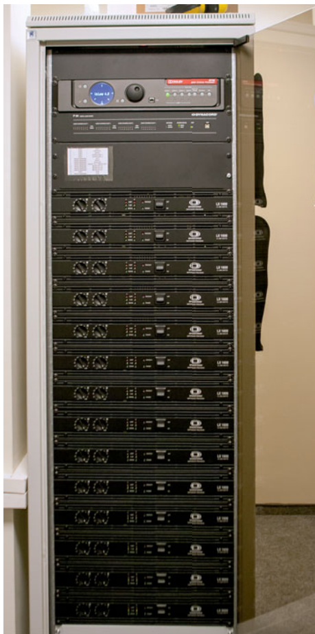
Szafa rakowa zawierająca czternaście wzmacniaczy Dynacorda – dwanaście LX 1600 i dwa LX3000...
