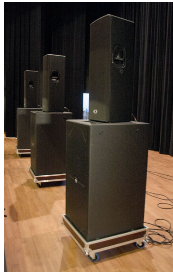
System główny, zaekranowy nagłośnienia kinowego stanowią trzy zestawy Dynacord VL212, wsparte subwooferami SUB28, również Dynacorda.
