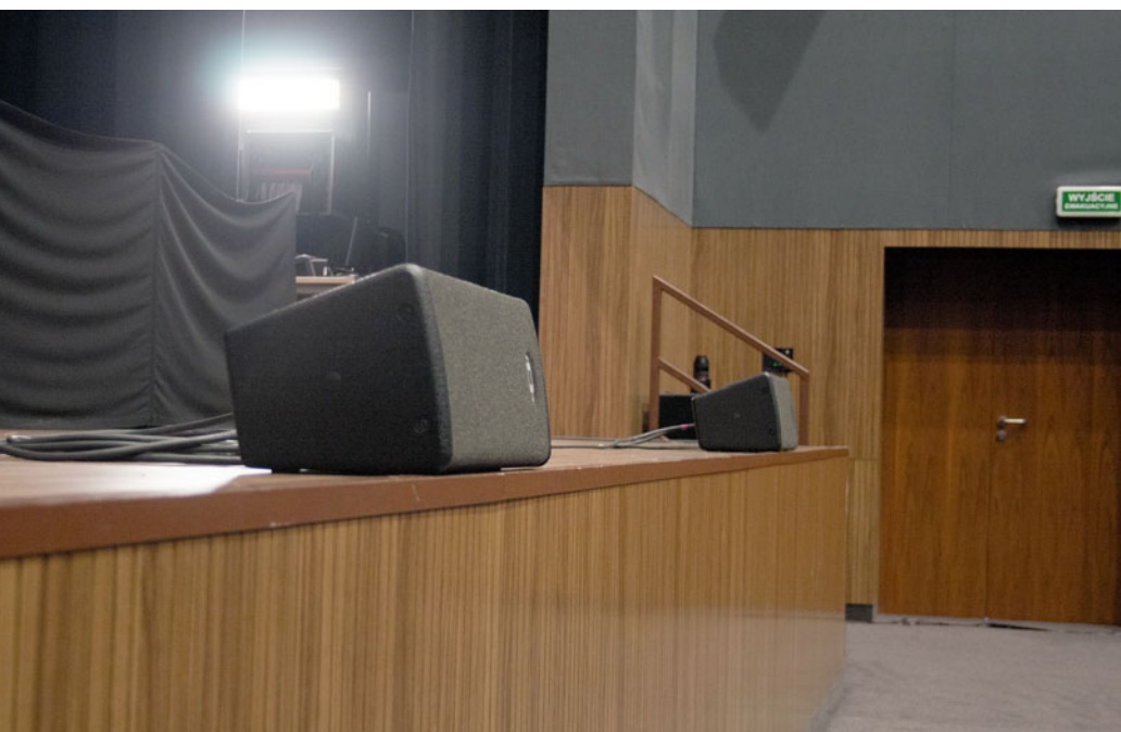
Jako frontfill, dogłasnający pierwsze rzędy, pracują dwa zestawy VL262 Dynacorda.
