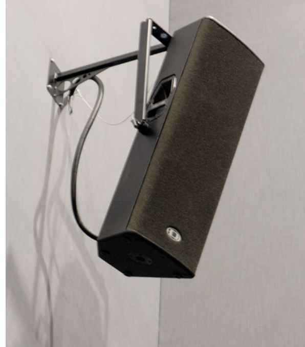
Gdy imprezą odbywającą się w MOK-u nie jest projekcja filmowa, a koncert, wówczas rolę nagłośnienia frontowego przejmują dwa zestawy VL212 zawieszane na ścianach po obu stronach sceny.
